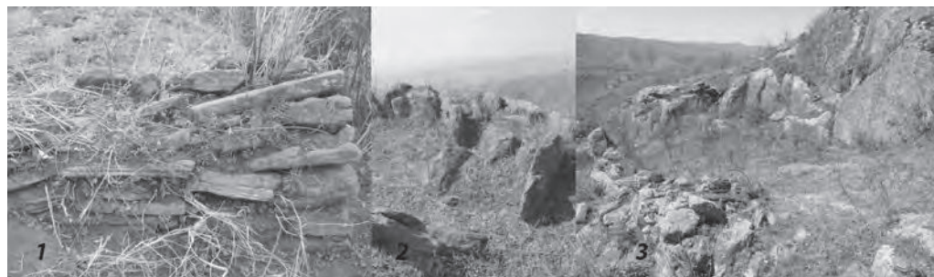
Figura 3. Diferentes muros: 1) Muro simple; 2) Muro doble; 3) Muro doble combinado con un afloramiento de rocas naturales
