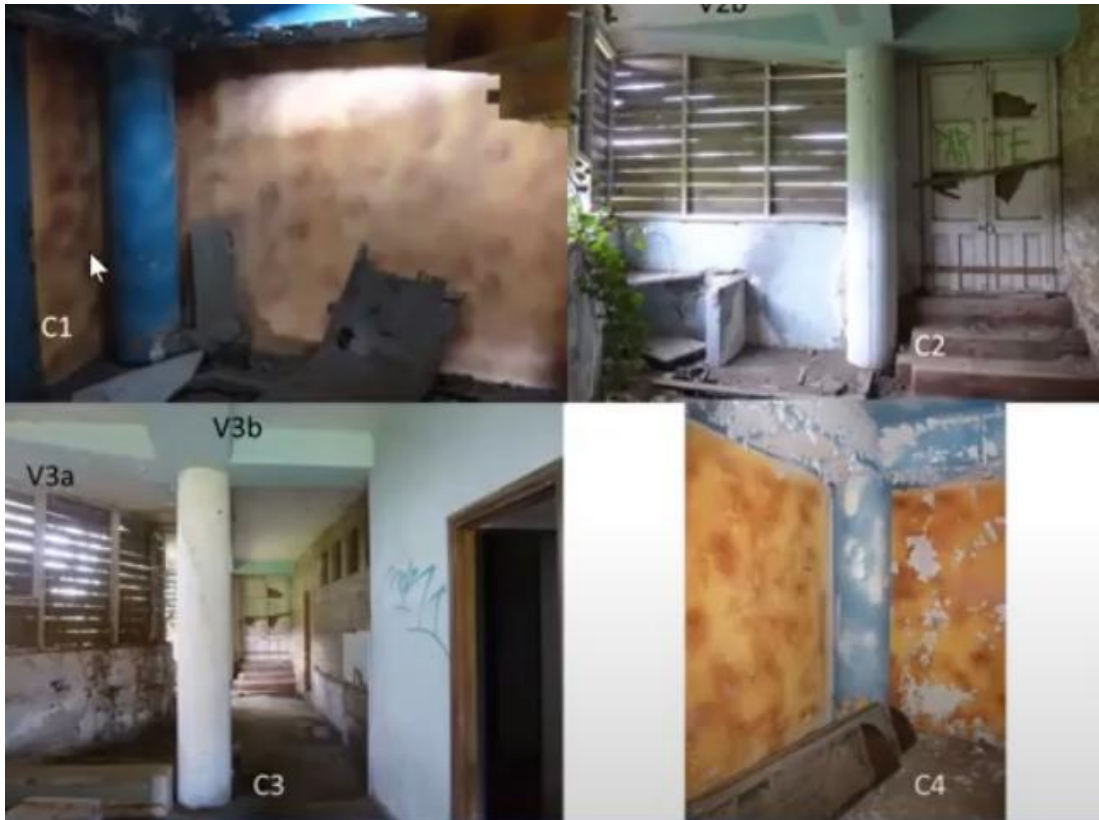
Columnas Planta Baja. Fuente: María Beatriz Valcarce, investigadora del CONICET
