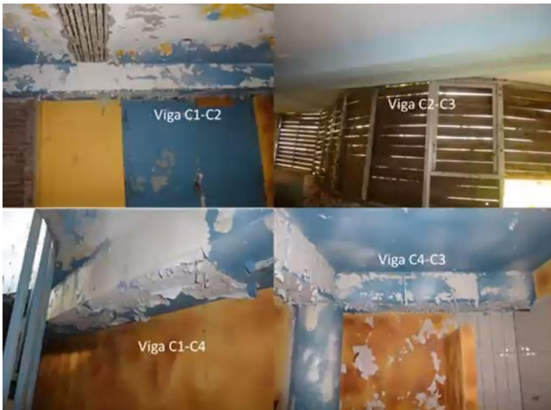
Vigas Planta Baja. Fuente: María Beatriz Valcarce, investigadora del CONICET
