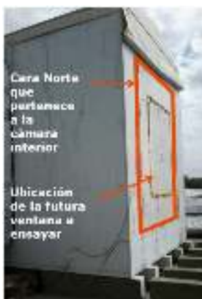
Figura 3: Vista de la Cara Norte
