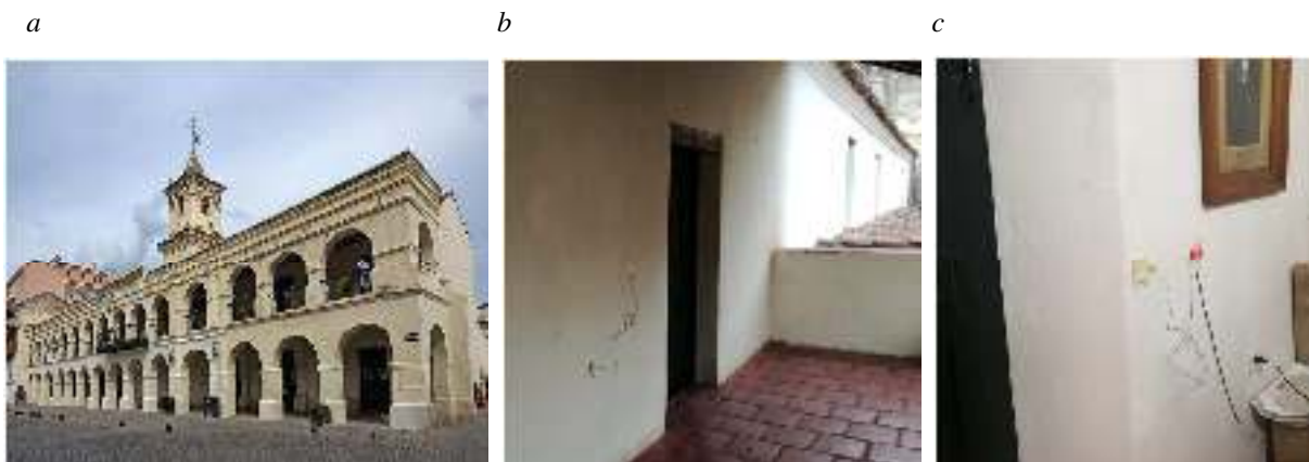
Figura 1: a) Cabildo de Salta, vista de la fachada norte. Muro sensado, b) lado externo y c) lado interno.
