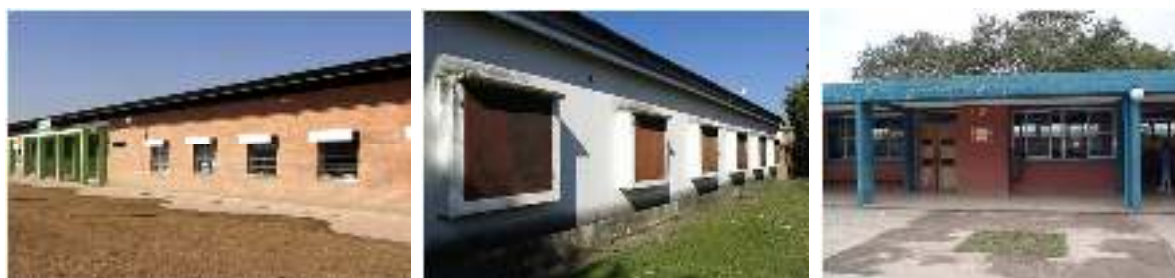
Fig.1: Vista de los muros exteriores de escuelas de Tucumán
