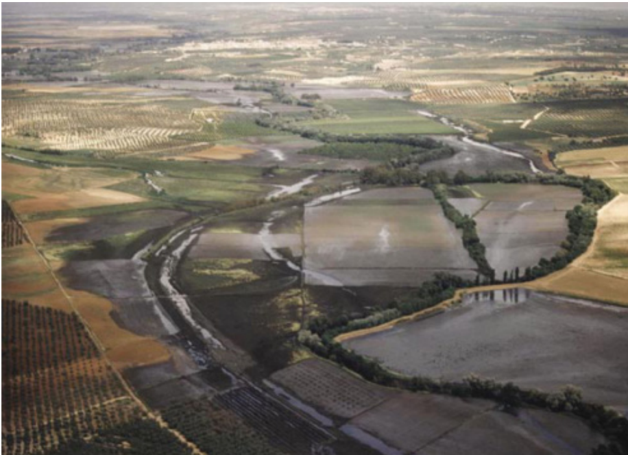
Figura 6. Vista aérea de parte del valle del Guadiamar tras el vertido. (Arenas et al. , 2008).
