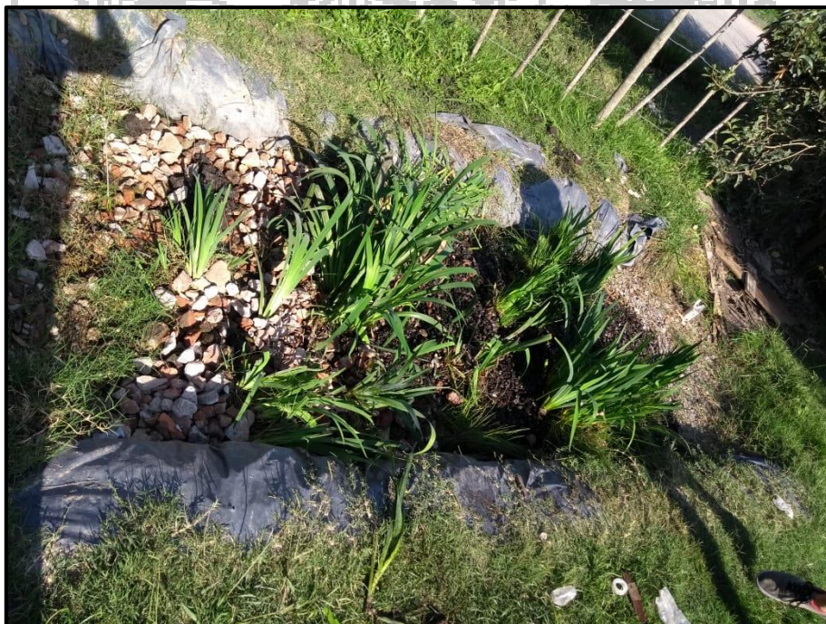
Foto 11: Humedal terminado con totoras implantadas
