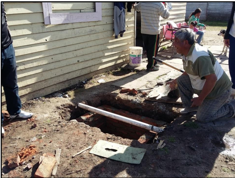
Foto N° 7: Construcción de la cámara séptica
