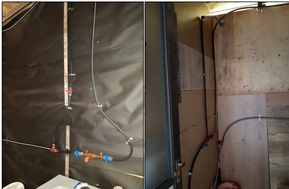
Foto N° 6: Instalaciones interiores del baño de la Copa de Leche
