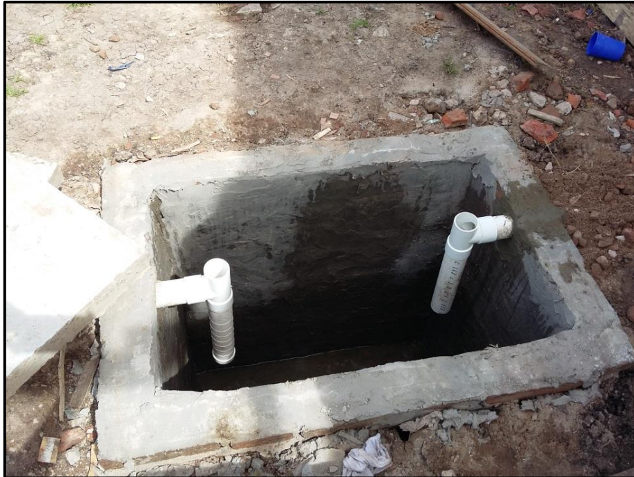
Foto N° 8: Cámara séptica terminada
