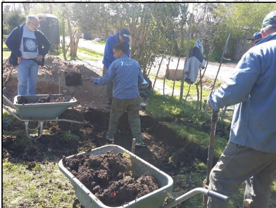
Foto N° 9: Cooperativa de trabajo realizando el humedal
