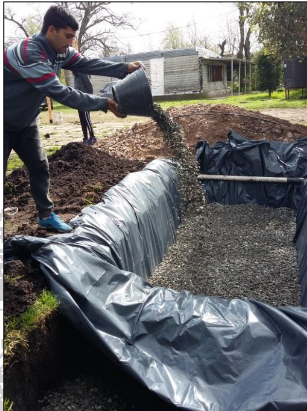
Foto N° 10: Relleno del humedal con piedra partida
