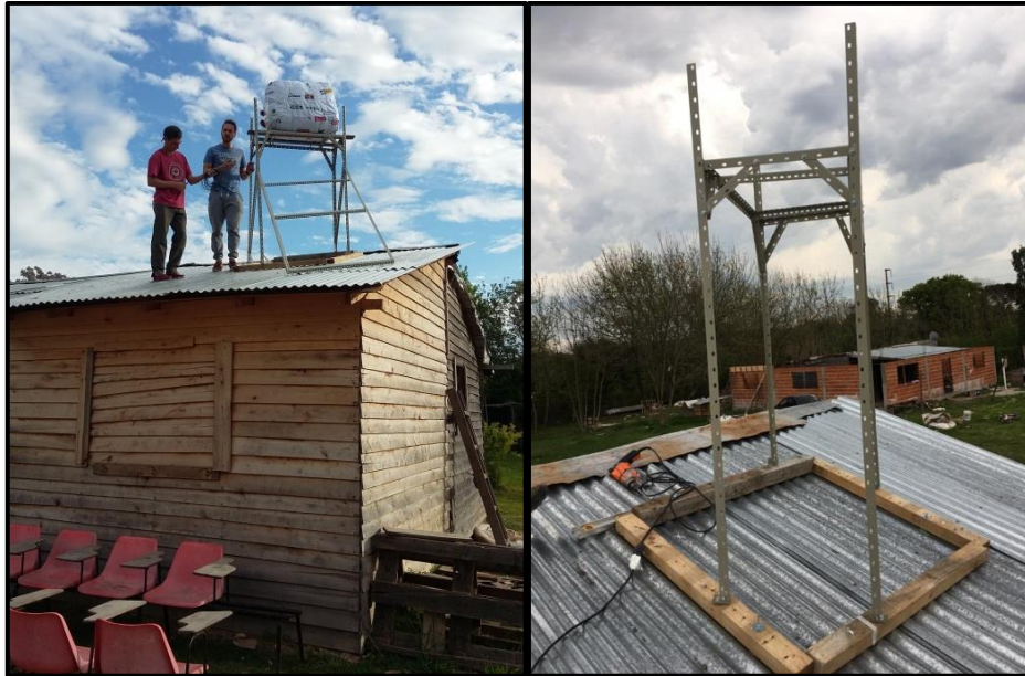
Foto N° 4: Soporte realizado para sostener el calentador solar
