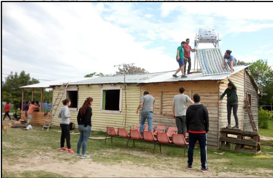
Foto N° 2: Grupo de trabajo instalando el calentador solar
