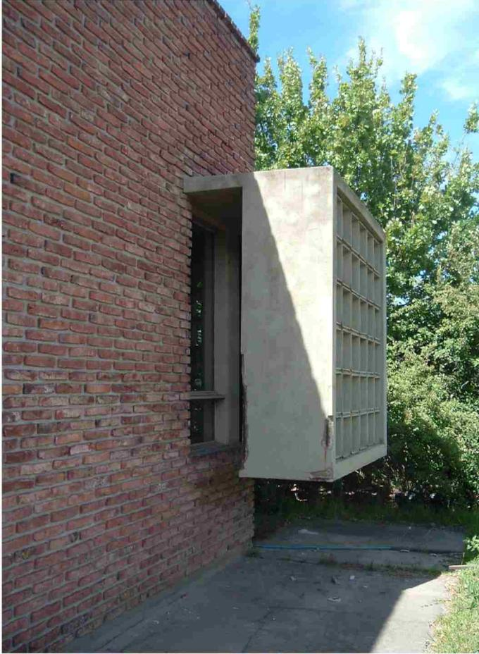
Los edificios que funcionaban como laboratorios cuentan con parasoles de Hormigón Armado, las paredes interiores se encuentran totalmente azulejadas y cuentan además con mesadas e instalaciones específicas de acuerdo a las necesidades de uso.
