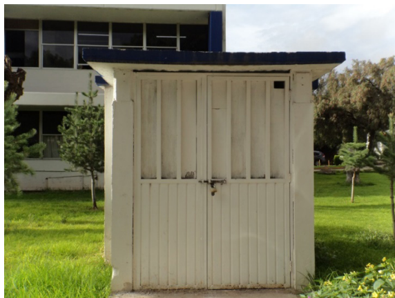
Figura No. 2. Almacén temporal para RPBI actual, no reúne los requisitos acordes a la Norma Oficial Mexicana (NOM 087).
