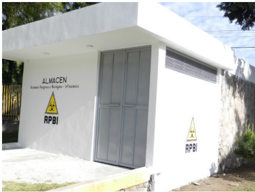
Figuras No. 5, 6. Fig. No. 5. almacén Temporal de la UAO/UAZ ya terminado, pero faltando algunas afinaciones externas e internas. Fig. No. 6. Aquí se muestran las dimensiones, ubicación, orientación y señalización de almacén temporal que reúne los requisitos de acuerdo a la NOM 087.
