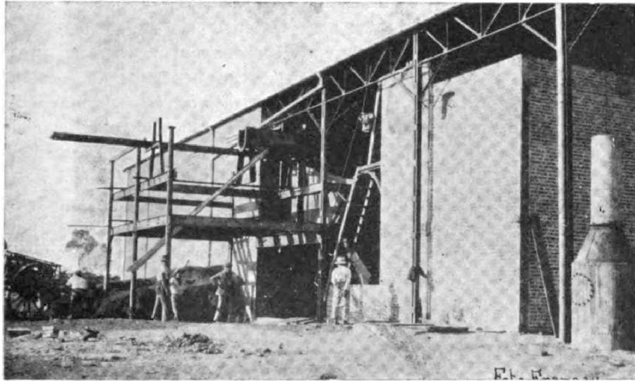
FIG. 6. — *Fábrica de tanino de la S. I. C. (Corrientes).* Esta fotografía muestra una parte de la sección calderas. Se ve en un extremo la canaleta (C) en cuyo interior un caracol transporta el exceso de aserrín, que no debe ser quemado en los hogares, y lo vuela al suelo. Se ve un montón de carbonilla (producto de la combustión defectuosa del aserrín) que es sacada con carros y se la aprovecha en el arreglo de caminos.
