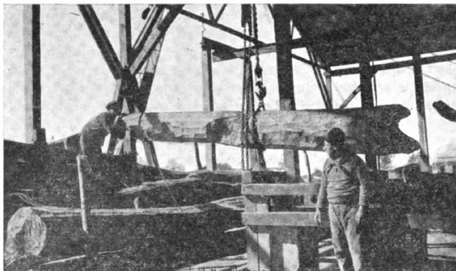
FIG. 5. — Fábrica de tanino «La Francia Argentina» (Resistencia). Obreros sorprendidos en el instante de proceder a la descarga de un pesado rollizo de quebracho. En las fábricas los vagones cargados con rollizos atracan frente al galpón de aserrineras y se procede a la descarga con grúas corredizas sobre rieles suspendidos del techo del galpón, que permiten depositarlos en las máquinas aserrineras.
