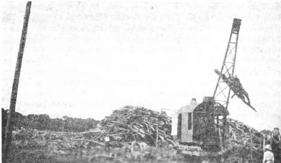
FIG. 3. — *Fábrica de tanino de la S. I. C.* (ciudad de Corrientes). Grúa trabajando en el canchón, en la carga de rollizos sobre vagones que serán llevados al galpón de aserrineras utilizando locomotoras de playa.
