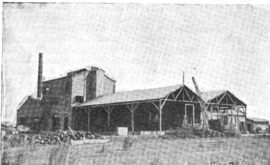
FIG. 4. — *Fábrica de tanino «La Francia Argentina»* (Resistencia). Vista de conjunto donde se pueden ver los galpones bajo los cuales funcionan las máquinas que reducirán los rollizos descortezados de quebracho a diminutas astillas, llamadas aserrín.
