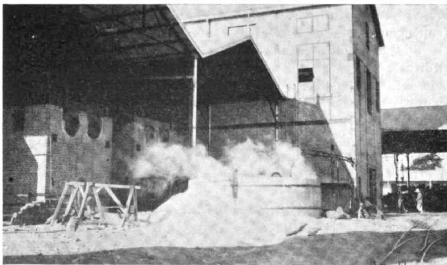
FIG. 7. — *Fábrica de tanino de la S. I. O. (Corrientes). Parte posterior de las calderas. Se ve el tanque T. D. (véase esquema N<sup>o</sup> 3) de descarga de los difusores, el edificio de la sección difusión y una parte del galpón donde funcionan las máquinas aserrineras.*
