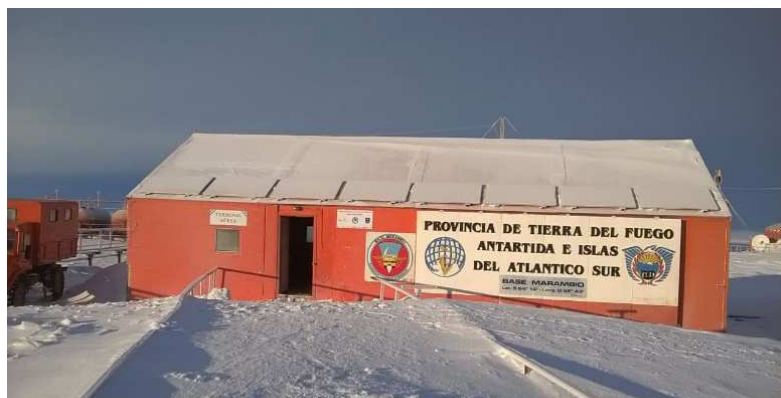
Figura 7. Fotografía del sistema fotovoltaico instalado en la Base Marambio luego de una nevada. Se destaca que a pesar de la nieve depositada el sistema estaba entregando energía a la red.
