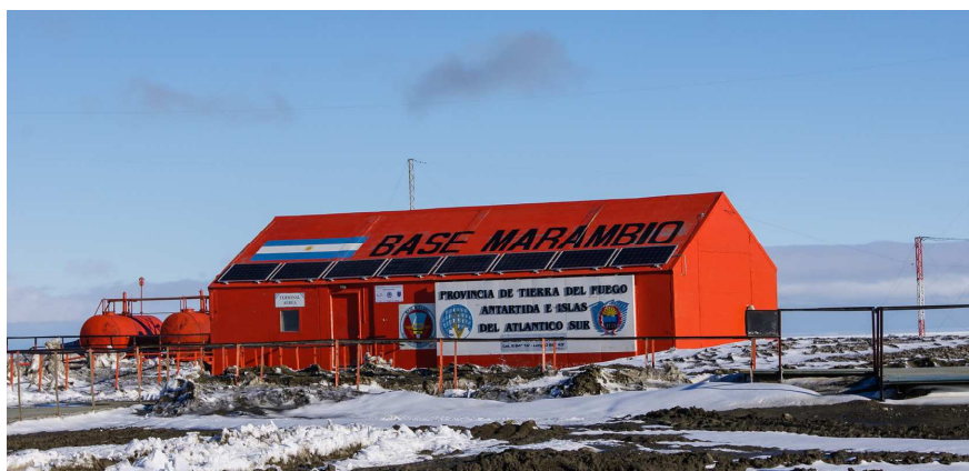
Figura 1. Fotografía del sistema fotovoltaico instalado en la Base Marambio.
