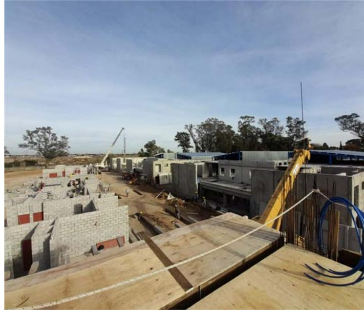
ves y a implementar distintas tecnologías de construcción para poder cumplir con los tiempos”, dice el ingeniero y ejemplifica: “En un mismo complejo se superponen obras de tecnología convencional, con encofrados deslizantes y otras totalmente prefabricadas. Esto implica un desafío técnico en la coexistencia de diferentes metodologías”.
