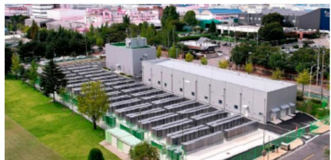
*Figura 5: Planta de generación de 4.2MW con tecnología SOFC de ciclo combinado en Corea del Sur [2].*
