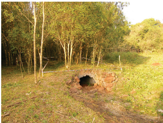
Figura 3. Vista general de estructura principal de Mártires 1. En primer plano, la boca del conducto
