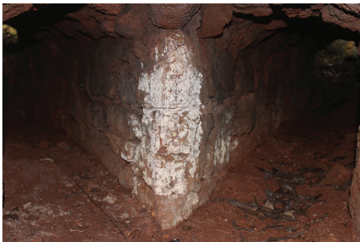
Figura 7. Sector de bifurcación del conducto subterráneo
