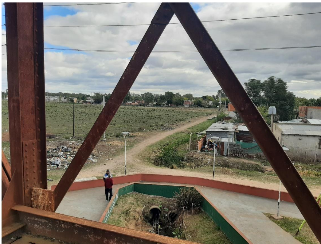
Imagen 10g. Sobre Puente de Hierro. A la izquierda, basural en 30 y 90. De fondo espacio verde vacante. Debajo, zanjón del arroyo Maldonado, continúa en el sentido de la vía ferroviaria en desuso. Viviendas ocupando esos lotes. Fuente: Fotografías propias
