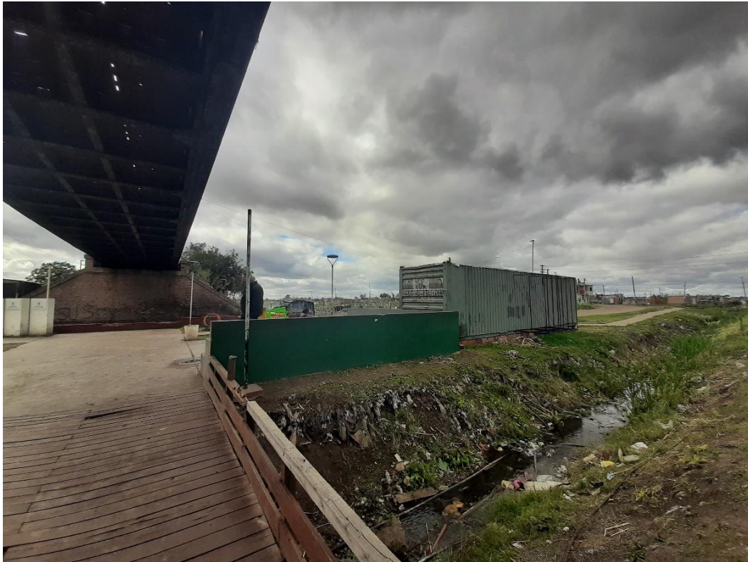
Imagen 10d. Basural sobre curso de agua debajo de Puente de Fierro. En el fondo casillas sobre proyección de calle 90 y Barrio Evita. Fuente: Fotografías propias
