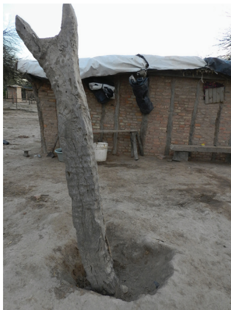
Figura 16. Casa Silva (agosto 2014): horcón que quedó en pie tras tres meses de desarmado el recinto; atrás la nueva construcción. Fotografía: Constanza Taboada
