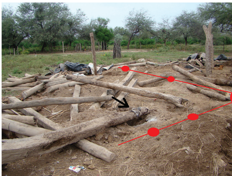
Figura 8. Casa Silva (mayo 2014): vista de los materiales desmontados in situ ; se indican con línea y puntos rojos la ubicación de algunos de los hoyos de horcones en distribución ortogonal; con flecha se indica el residuo negro y blanco presente en la base de poste. Fotografía: Constanza Taboada
