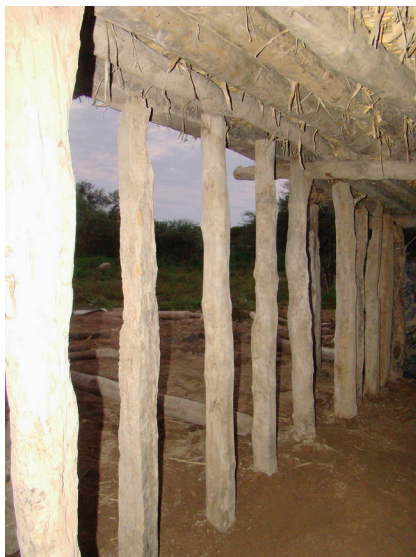
Figura 13. Casa Silva (mayo 2014): vista interior de la ubicación de postes para confección de los muros y techo del nuevo recinto. Fotografía: Constanza Taboada
