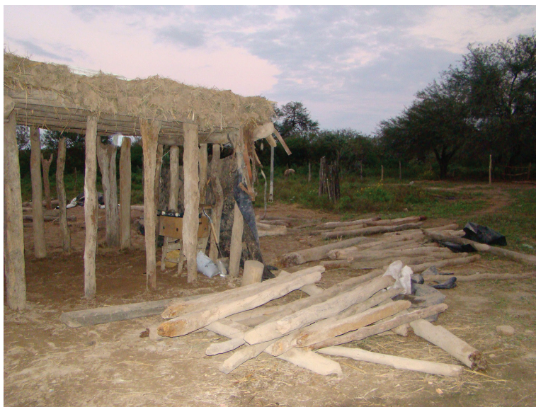
Figura 11. Casa Silva (mayo 2014): nuevo recinto en proceso de construcción reutilizando los materiales del recinto desmantelado. Fotografía: Constanza Taboada
