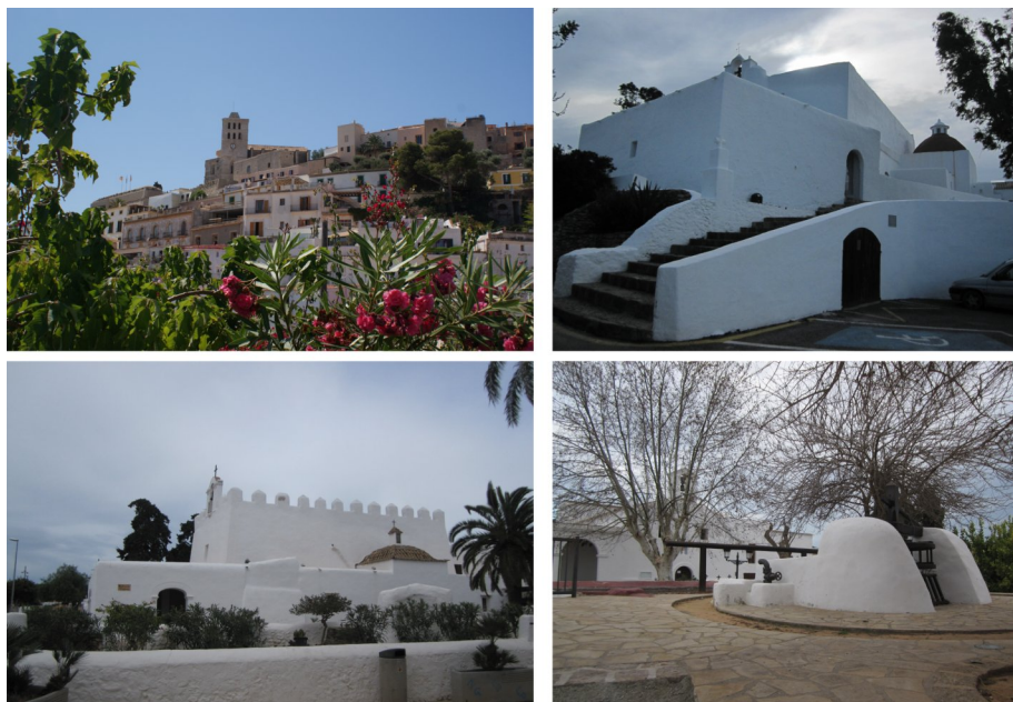
Figura 1. Cuatro de las Iglesias más antiguas de la isla de Ibiza. Arriba a la izquierda vista de la Catedral de Ntra. Sra. de la Nieves en lo alto de la parte antigua (D'alt Vila) de la ciudad de Ibiza. A su derecha se observa el castillo. En esta zona es posible que en época musulmana existiese una mezquita que diese servicio a la población musulmana. Arriba a la derecha, iglesia de Sta. Eulalia del Río, reconstruida en el siglo XVI sobre un templo anterior destruido en una razia berberisca, domina desde un alto la población homónima y la desembocadura del único río de las Baleares. Abajo a la izquierda, iglesia de San Jorge de las Salinas. Nótese las almenas que le dan el aspecto defensivo que en origen tuvo, pues una característica de las iglesias Pitiusas es que se construyen con muros anchos y pocas aberturas al exterior para hacer frente a posibles asedios. Abajo a la derecha, iglesia de Ntra. Sra. en Jesús. Este templo fluctuó entre dar servicio a la población rural del entorno de Ibiza a ser sede de diversas congregaciones monacales, destacando los dominicos. Imágenes del autor.
