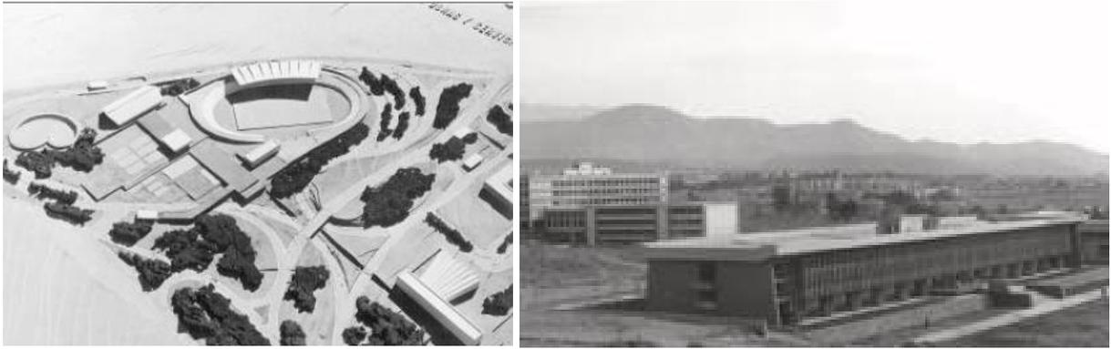
*Fig. 82 Maqueta del proyecto de la UNCuyo, 1967. Se observa que los cruces entre las circulaciones vial y peatonal son a desnivel. Este criterio, vista la topografía del terreno, era una óptima solución no concretada. Fuente: CDH UNCuyo*
