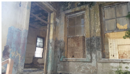
Fig. 11 - Interior pabellón San Camilo
