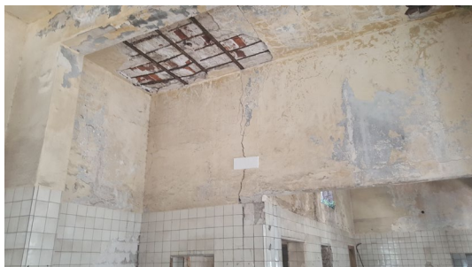
Fig. 10 - Interior pabellón San Camilo
