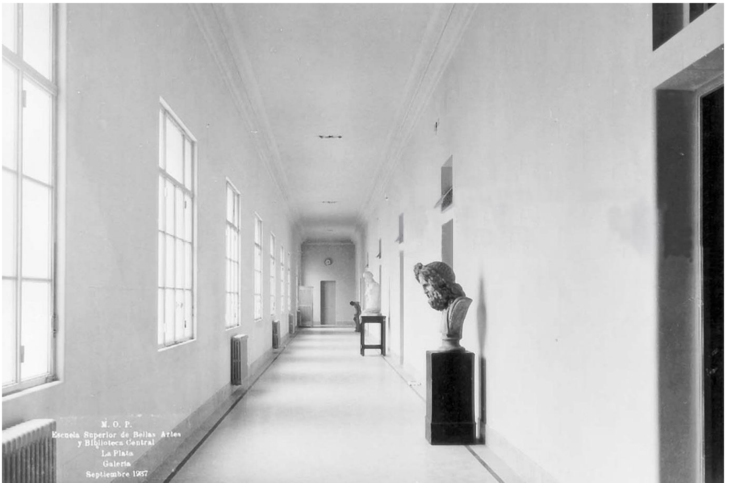
HALL CENTRAL Y GALERÍAS –ESCUELA SUPERIOR DE BELLAS ARTES–
