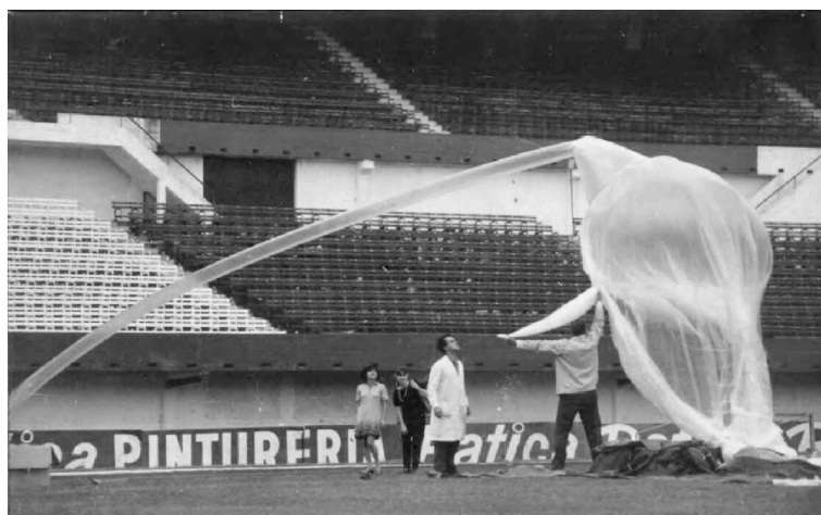
Figura 7 Lanzamiento de un globo estratosférico. Desde la izquierda hacia el centro de la imagen se visualiza la manga con la que se llenaba la burbuja de gas, que aparece hacia la derecha. Aparecen en la foto L. Opradolce, C. Falcón y Vicente Mugheri.
