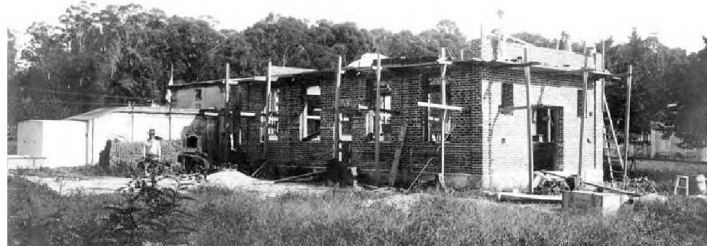
Figura 10 Construcción del taller mecánico (fecha: anterior a 1913, año en el que se terminó de construir el taller).
