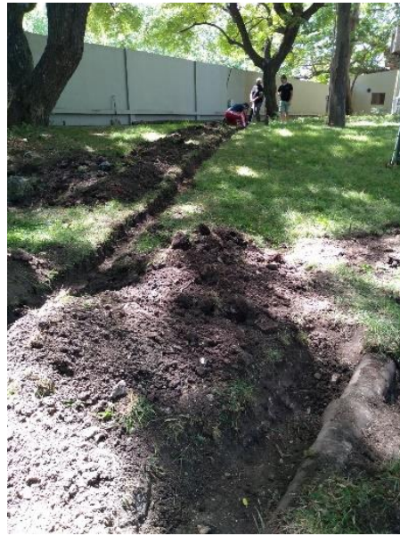
Fig. 2 – Línea cercana a futuro deposito
