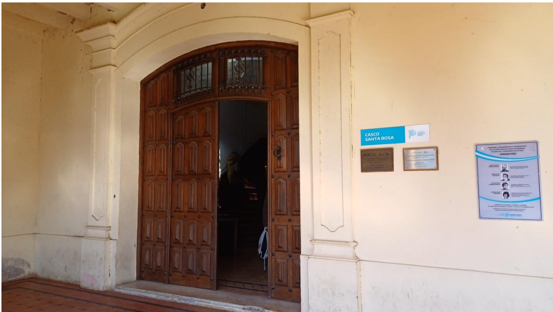
Figura 12. Casona Santa Rosa. Entrada principal (2024).
