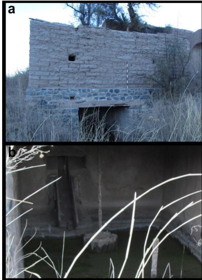
Figura 6.33: piso superior e inferior del R6. Referencias: (a) piso superior de la sala y el cárcavo del R6; (b) Detalle del saetín, del rodezno y del árbol.
