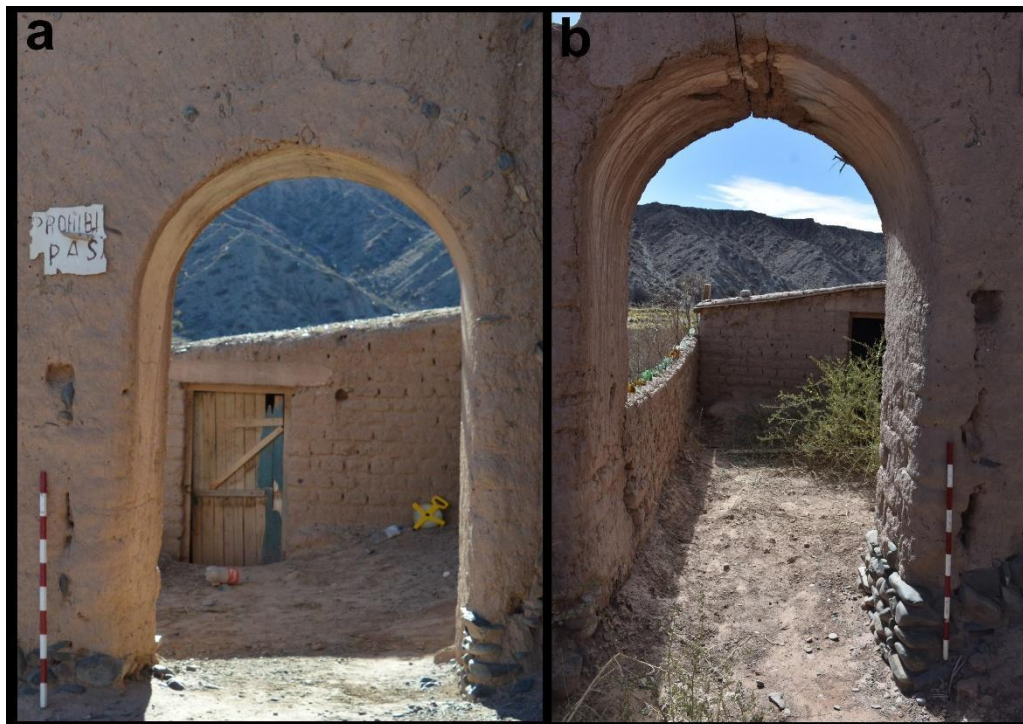
Figura 6.18: detalle de las arcadas. Referencias: (a) detalle de las rocas sedimentarias planas en parte superior y a los lados de la primera arcada del muro SE desde el exterior y su vínculo con la abertura principal del R6; (b) detalle de la arcada vinculada a muro construido en la actualidad con vidrios en su parte superior.
