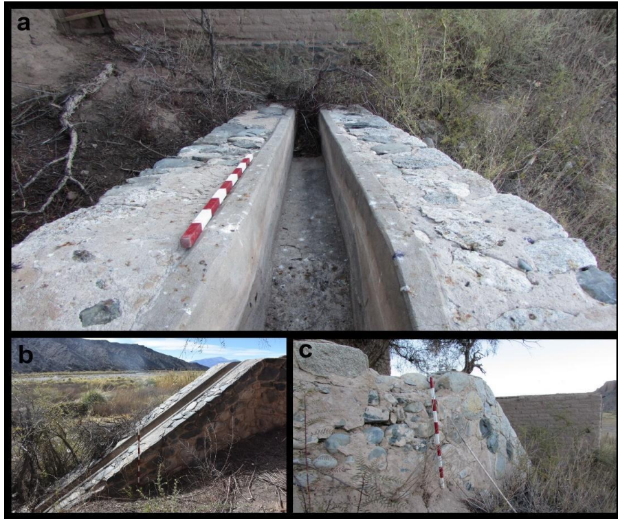
Figura 6.32: la acequia. Referencias: (a) el muro NW del R6 y el tramo final del canal; (b) la acequia y su pendiente más pronunciada; (c) evidencias de deterioro.
