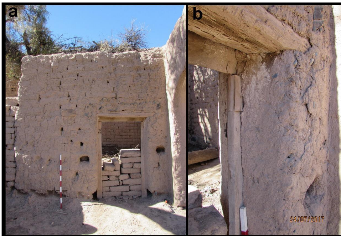
Figura 6.13: R3. Referencias: (a) muro SW con posibles respiraderos tapados y la abertura principal; (b) detalle del dintel de cardón en la abertura principal del R3 desde el exterior y rocas sedimentarias planas por encima.
