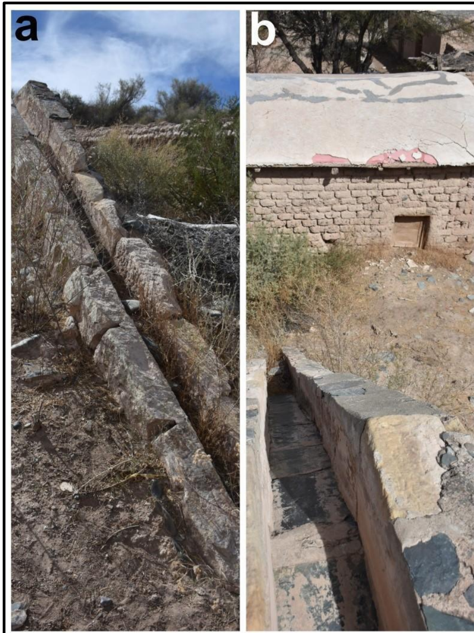
Figura 5.14: acequia del molino de Laxi. Referencias: (a) últimos tramos de la acequia con pendiente pronunciada; (b) acequia y vista exterior de la habitación de molienda con intervenciones de mantenimiento actuales en el techo.
