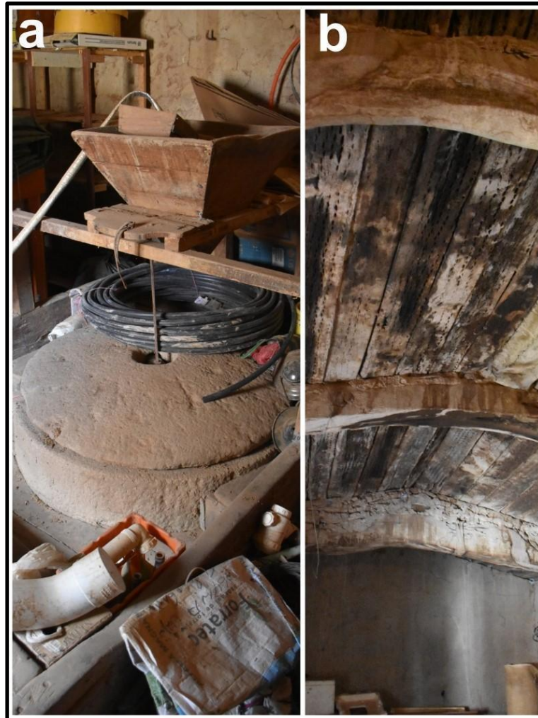
Figura 5.13: habitación de molienda del molino de Laxi. Referencias: (a) maquinaria de molienda al interior de la habitación; (b) techo de cardón y tirantes de algarrobo.
