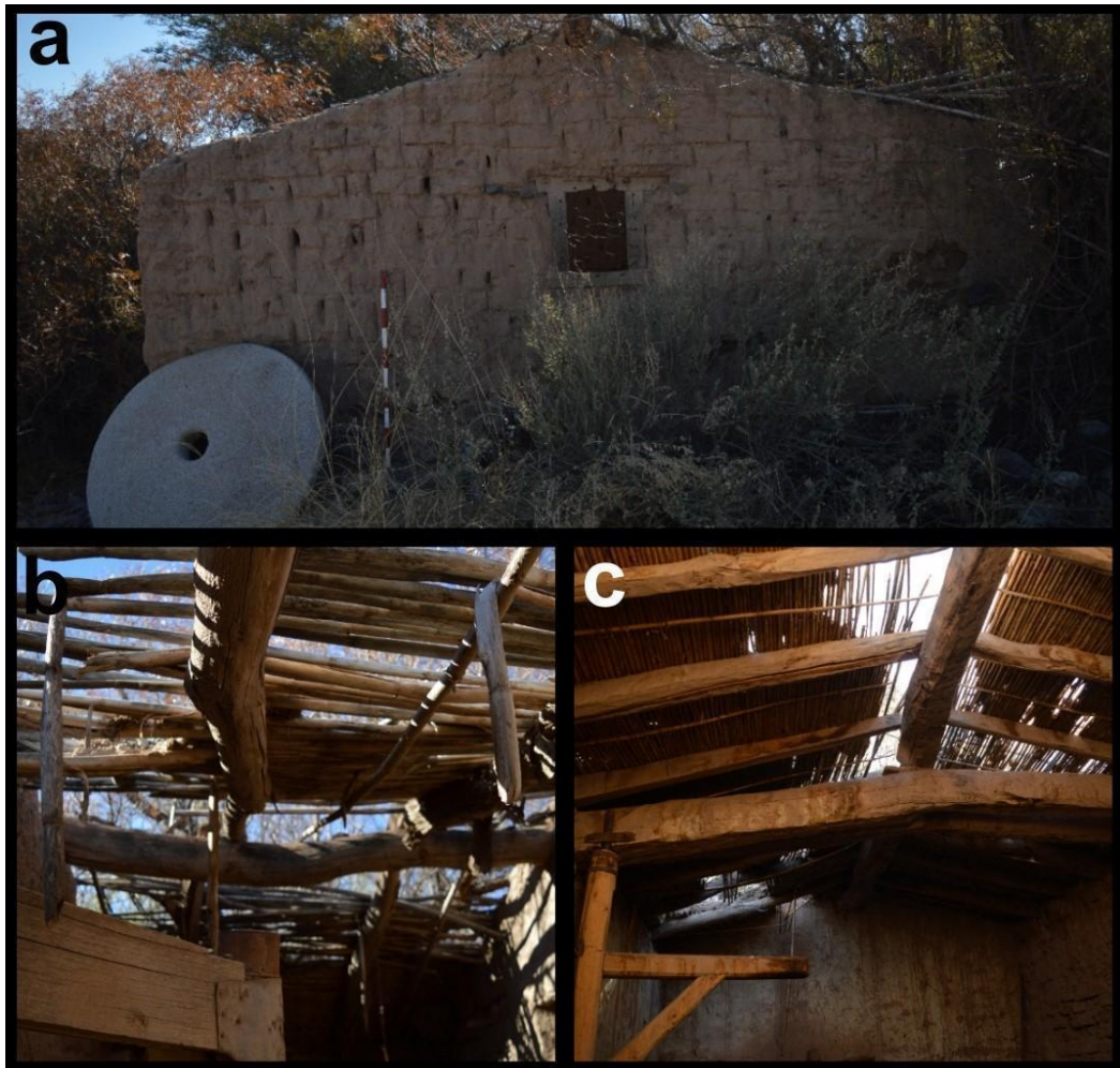
Figura 5.9: molino hidráulico de rodezno horizontal de Ruiz de los Llanos en el departamento de Cachi. Referencias: (a) vista exterior de la habitación de molienda con piedra móvil desacoplada; (b) deterioro de techo de caña al interior de la habitación de molienda; (c) deterioro de techo de caña con tirantes de algarrobo y cabría al interior de la habitación de molienda.
