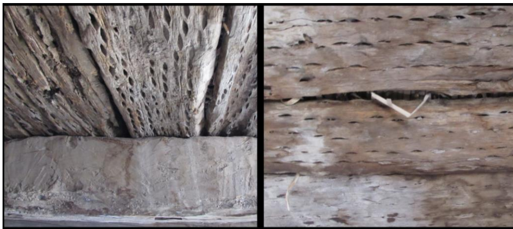
Figura 6.31: detalle del techo: vigas de algarrobo, entablado de cardón y jarilla.
