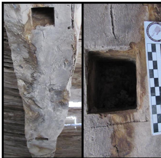
Figura 6.29: depresiones rectangulares que podrían haber sostenido una grúa o cabria en la viga del techo del R6.
