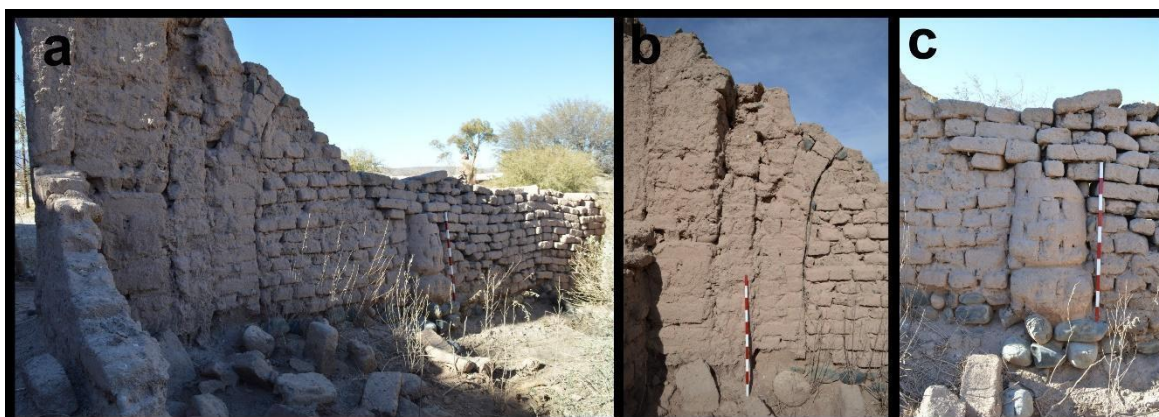
Figura 6.20: muro SE del R5 desde el interior. Referencias: (a): arcada cegada y restos de columna; (b) detalle arcada; (c) detalle restos de columna.
