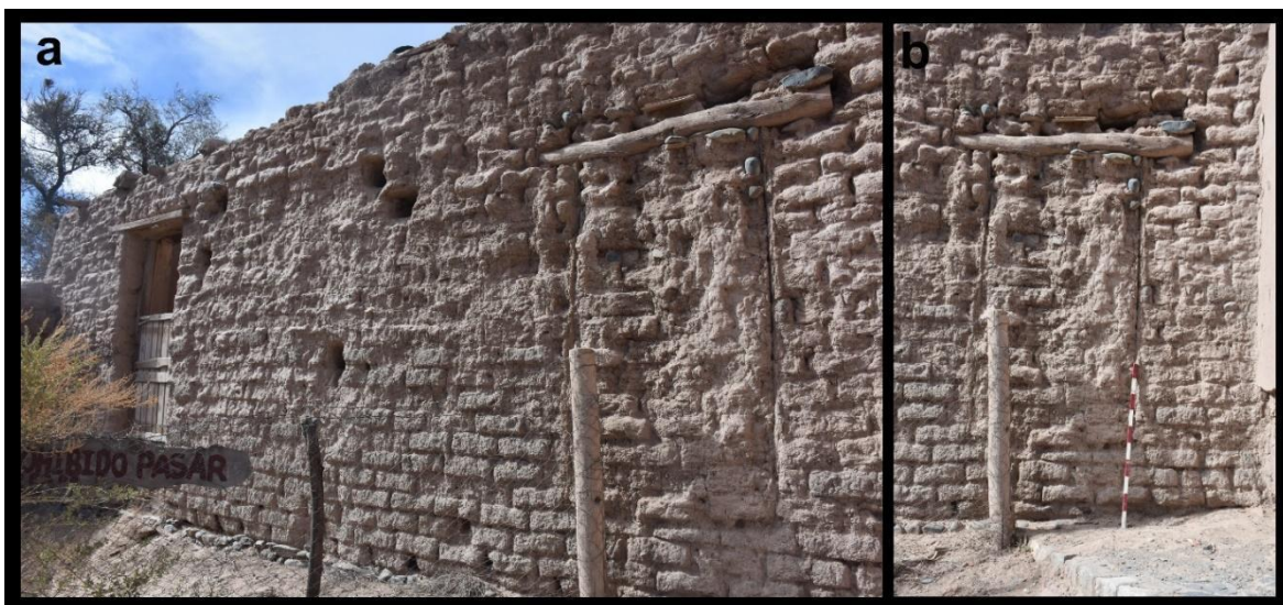
Figura 6.10: puerta cegada del R1 en el muro SW y su vínculo con el R2. Referencias: (a) detalle puerta R1 y el R2; (b) detalle puerta cegada del R1 y dintel de algarrobo.
