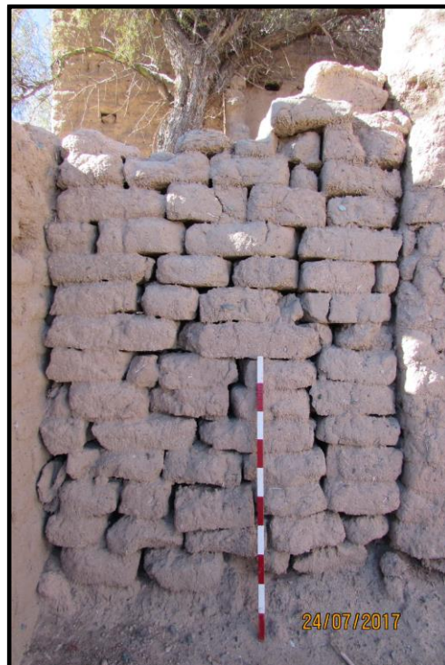
Figura 6.15: apilamiento de ladrillos de adobe anexo al muro SW del R3.
