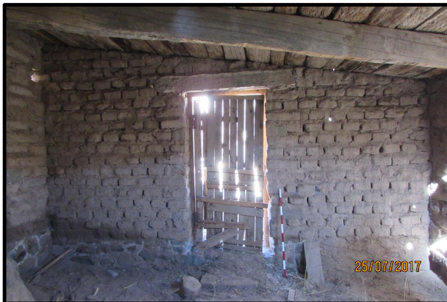
Figura 6.26: vista interior del muro SE del R6, la abertura, el dintel de cemento y el piso de tierra de la habitación.
