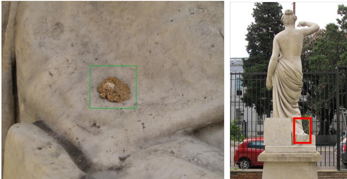
Figura 13. Lucio Correa Morales, La Arquitectura (1884). Detalle de depósitos exógenos. Registro fotográfico de Luis M. Ferreyra Ortiz
