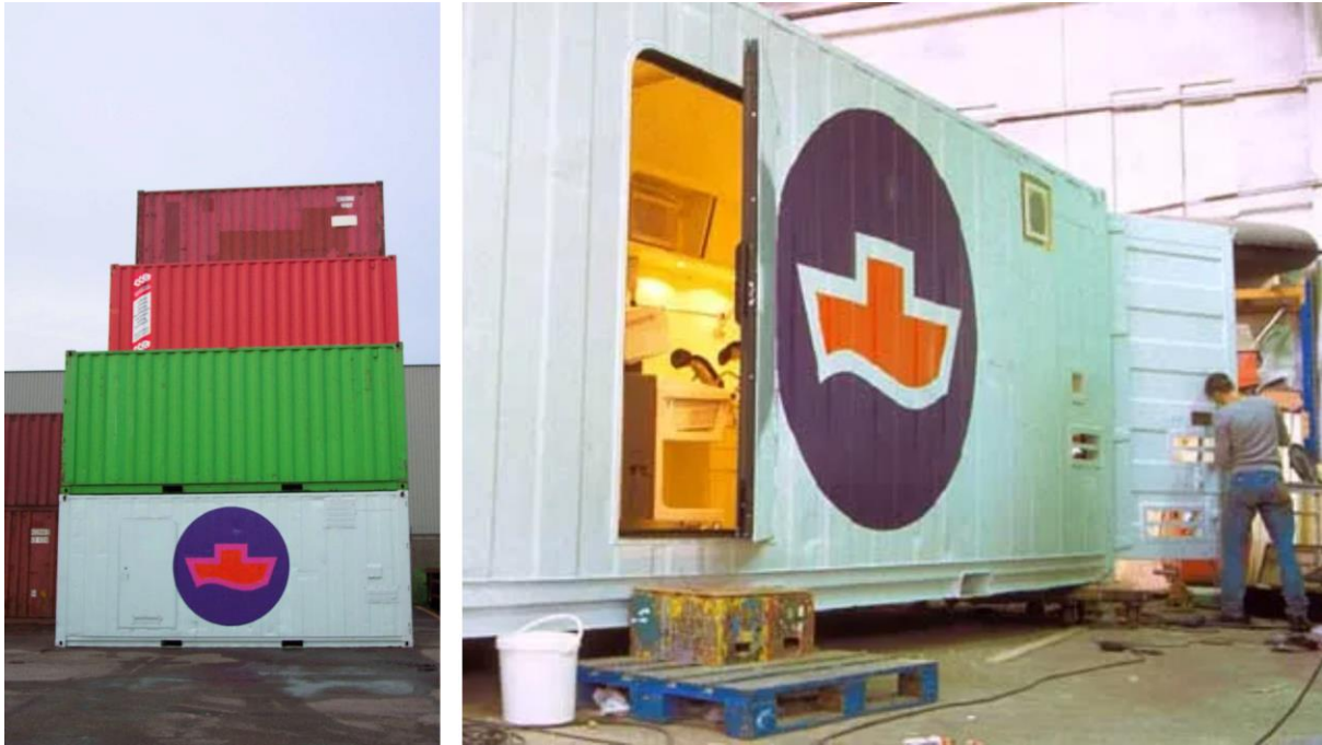
Figura 3. A-Portable en el depósito de containers (izquierda) y durante su construcción en Atelier van Lieshout (derecha)
