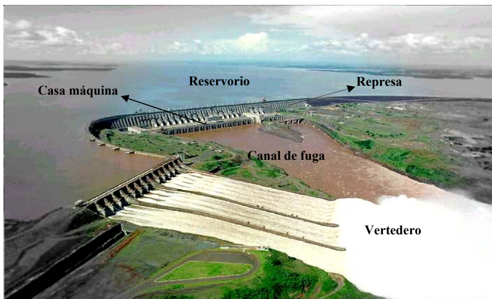
Figura 1: Componentes de una central hidroeléctrica
