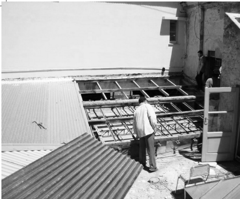
Trabajos de reparación de cubiertas inclinadas
