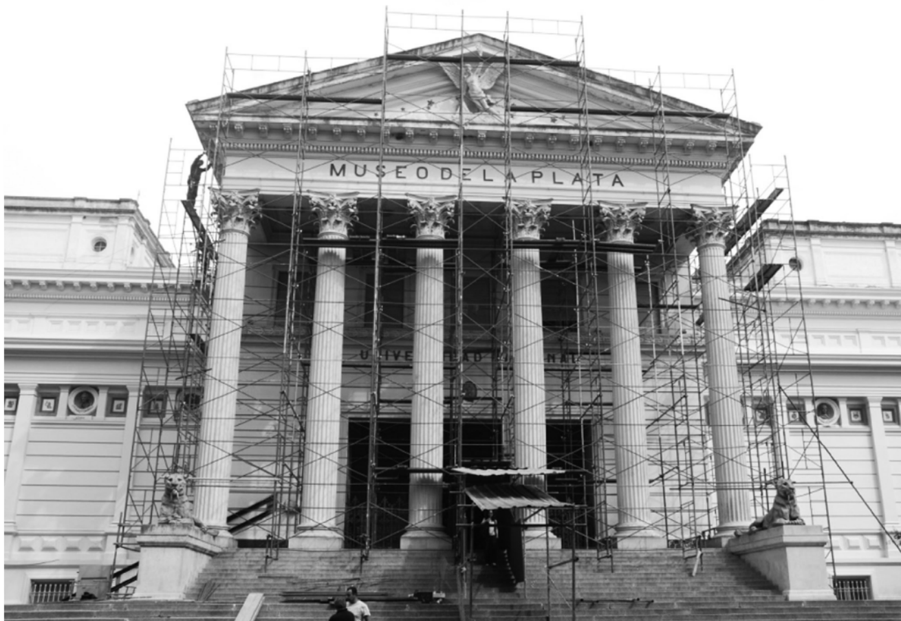
Trabajos en fachada principal.
