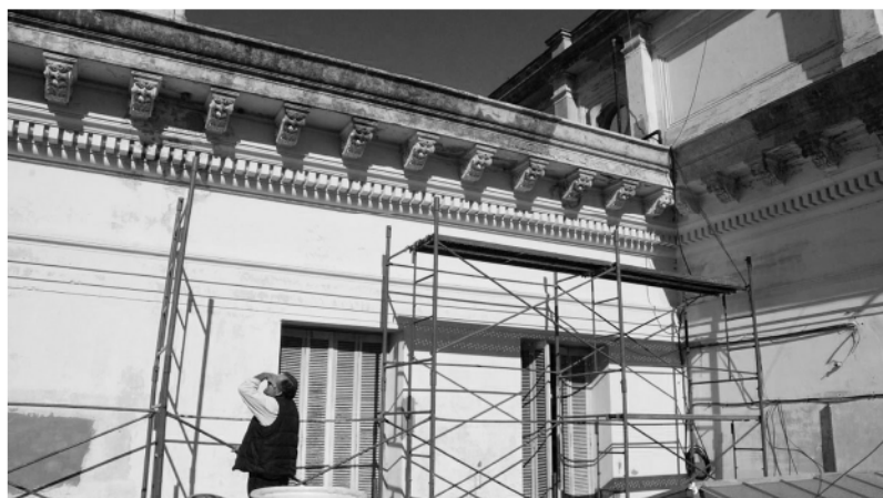
Trabajos de recuperación de fachadas.
