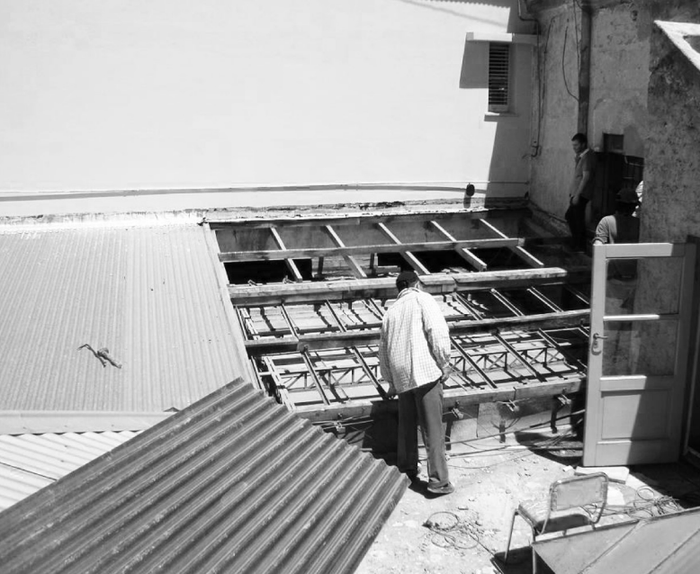
Trabajos de reparación de cubiertas inclinadas
