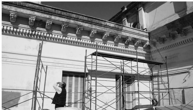
Trabajos de recuperación de fachadas.
