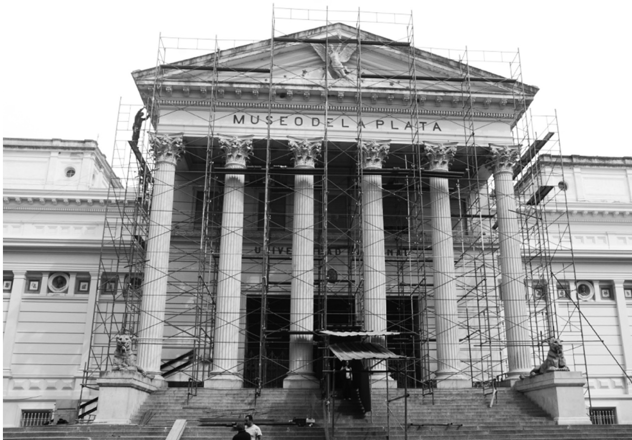
Trabajos en fachada principal.
