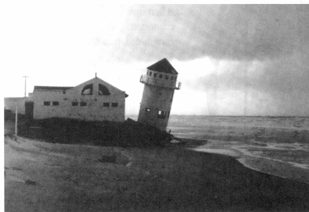
Fig. 8. Erosión de la playa y destrucción de inmuebles en Pinamar durante la tormenta del 8 de junio de 1993.
