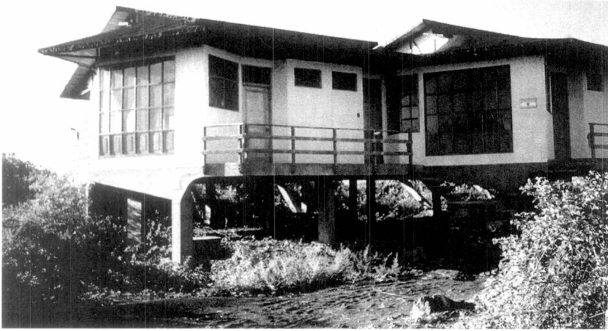
Fig. 7. Alojamiento para investigadores en la Estación Científica Charles Darwin.
