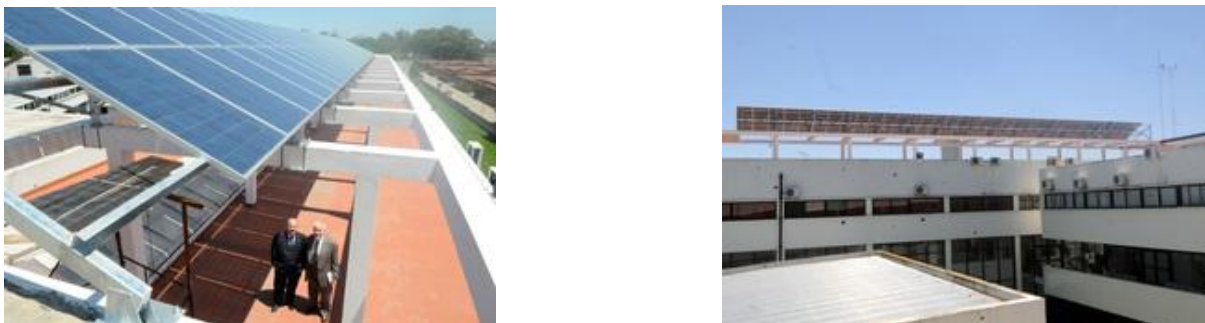
Figura 1. Disposición física los paneles fotovoltaicos.
