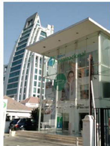
Figura N° 9: Obra nueva. Edificio comercial. Calle La Pastora, 2014
