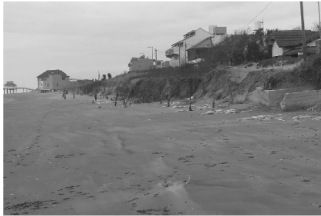
Figura 6. Destrucción del frente medanoso costero en el norte de Las Toninas (Buenos Aires). Se pueden observar los pilotes que habían sido emplazados para contener un relleno de arena con propósitos de defensa ante la erosión
