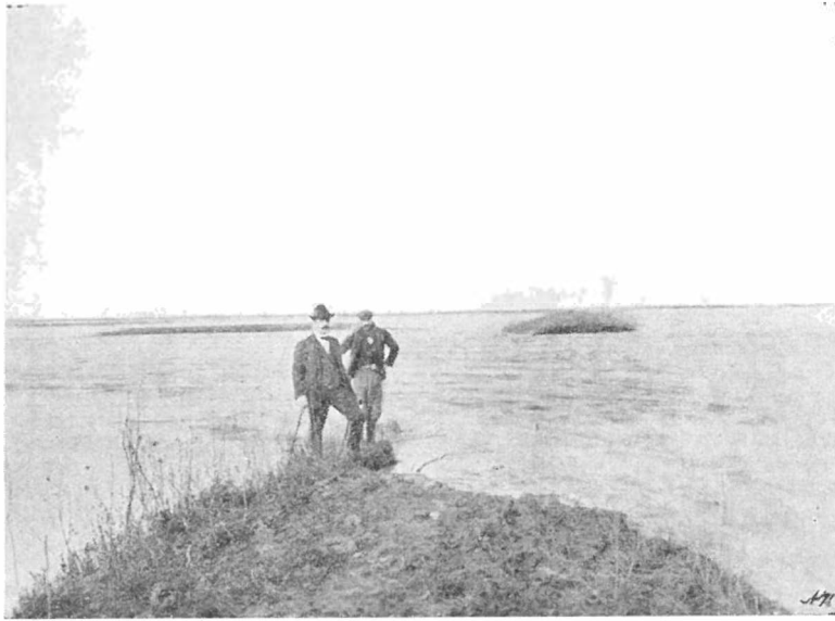
Una brecha del canal Nº 16 en campo del Sr. Delia. 21/7.1919
