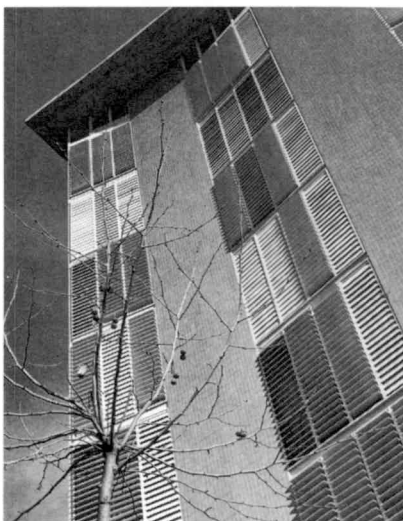
Arribar: casa Ugalde. J. A. Coderch. Abajo: Edificio de departamentos en la
