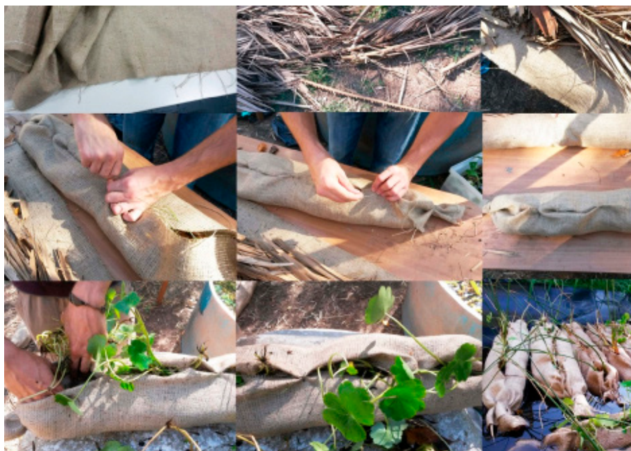
Figura 4. Secuencia del armado del biorrollos para implantación de helófitas nativas. Figure 4. Sequence of the manufacture of prevegetated rolls for the implantation of the native helophytes.
